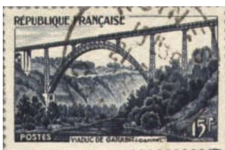
Viaduc de Garabit (1882)
